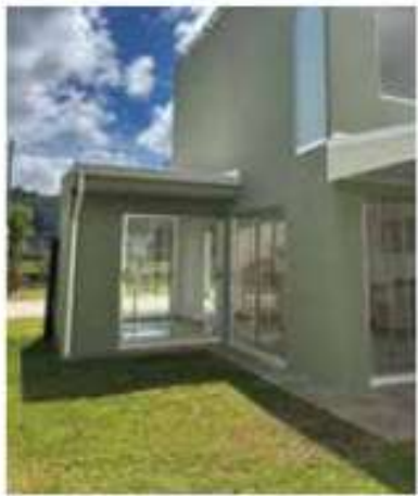
Casas separadas para mayor privacidad
